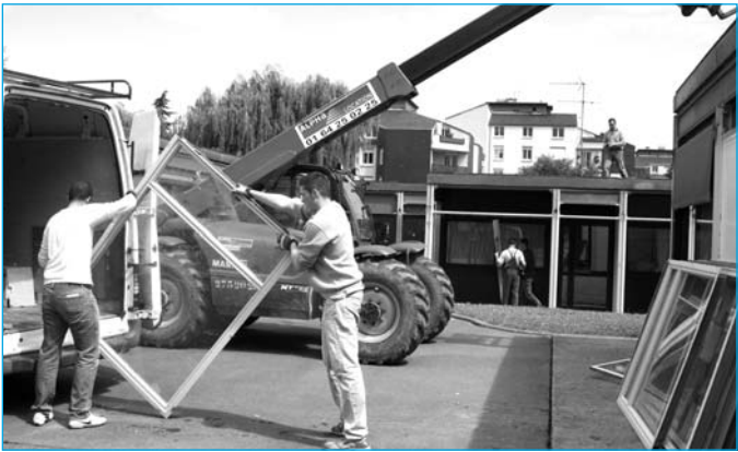
Réfection des couvertures et isolation des façades de l'école élémentaire de l'Allée-des-Bois.
