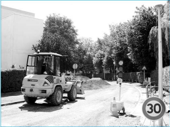
Quartier du Bois-de-la-Grange, poursuite des travaux de rénovation des réseaux d'assainissement.
