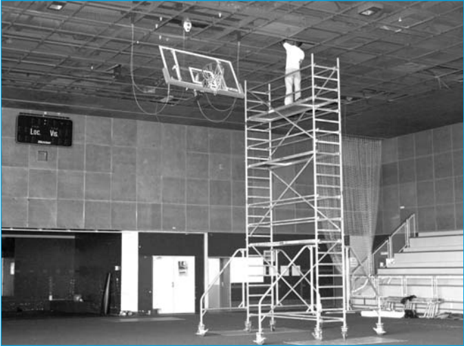
Travaux de renforcement de l'éclairage de la grande salle du Cosom.
