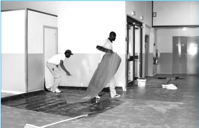
Remplacement du revêtement de sol du hall d'entrée de la salle polyvalente et sportive de la Ferme-du-Buisson.
