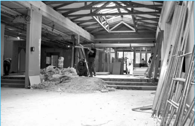
Chantier d'aménagement intérieur de la future Maison de l'enfance et de la famille (Mef).
