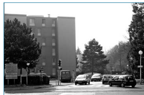
La rue du Bois-de-la-Grange, desservant tout le quartier, restera accessible durant les travaux.
