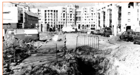
Chantier d'aménagement de la voirie du cours des Roches, avec à gauche, le chantier du futur bâtiment abritant l'École nationale de musique, l'auditorium, la mairie annexe, la Maison pour Tous et au fond à gauche, la construction du Centre omnisports du Luzard.
