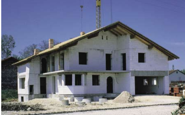
Construction en béton cellaire
