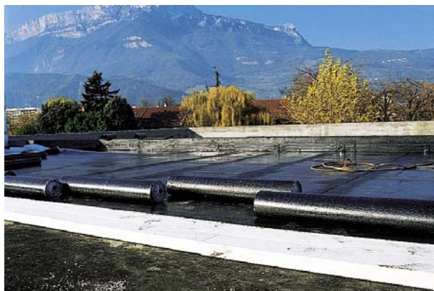
L'isolation d'une toiture-terrasse
