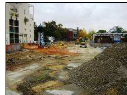
7 - Travaux du pôle gare
