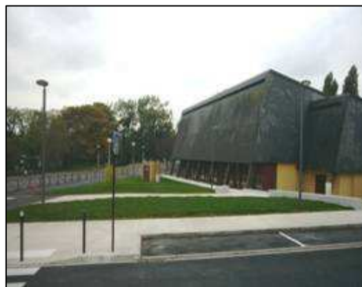
5 - Travaux d'aménagement du parvis de la SPS
