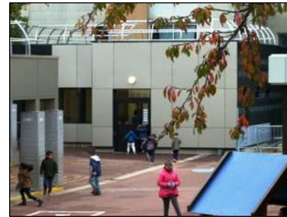
3 - Construction d'un bâtiment modulaire à l'école de l'Allée-des-Bois maternelle
