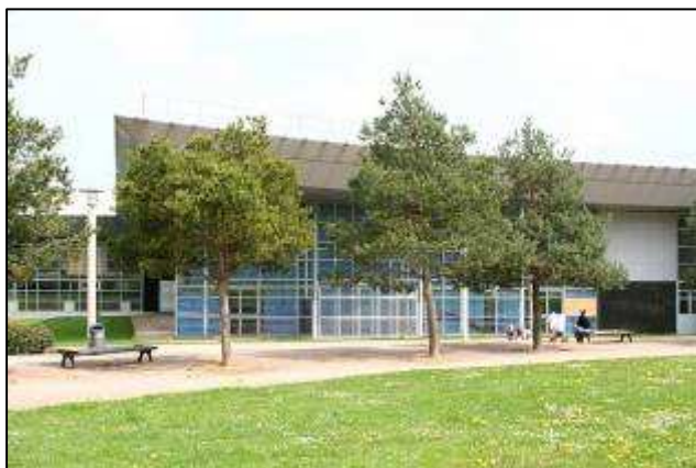
1 - Travaux de réhabilitation du COSOM
